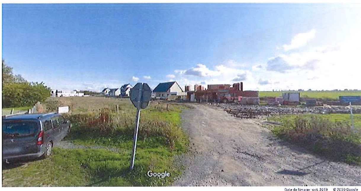
Illustration 13: Vue plus large de la zone selon prise de vue identifiée en rouge sur l'illustration 2 - Maison construite à droite, terrain à bâtir à gauche - Google Earth
