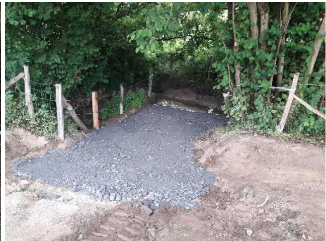
La Seulles après restauration (Jurques)
