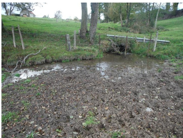
Le Canflais avant travaux (Cahagnes)
