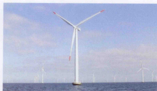
Hauteur du mât : 100 m
