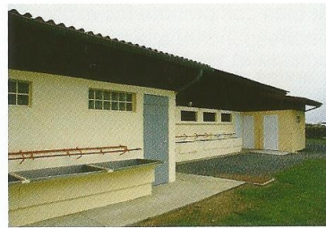
Amélioration du bloc sanitaire
