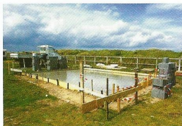
Dalle béton du point multi-services
