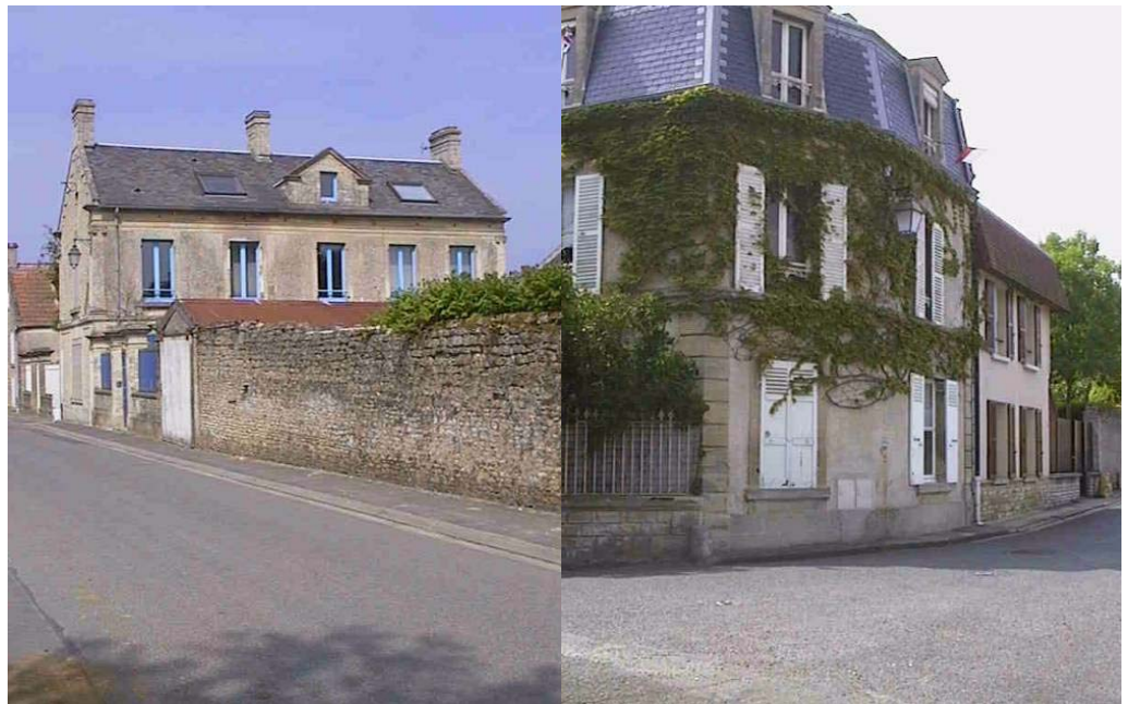
A gauche, maison rectangulaire. A droite, toiture à la Mansard sur une construction située rue Grande
